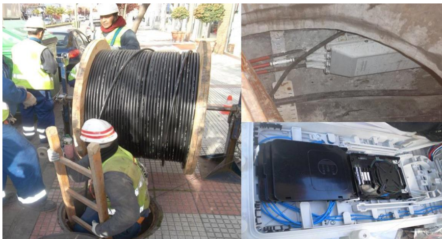
Ilustración 14. Tendido y empalme de cables en canalización.
